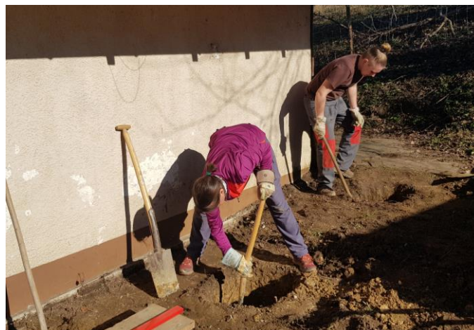
Stina Klee und Jonas Melcher heben Löcher aus für die Fundamente des neuen Anbaus.
