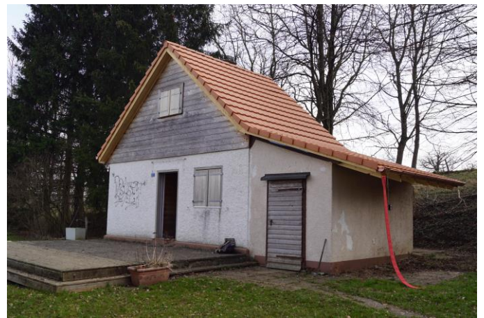
Das Freizeithaus auf dem Stutz mit frisch gedecktem Dach.
